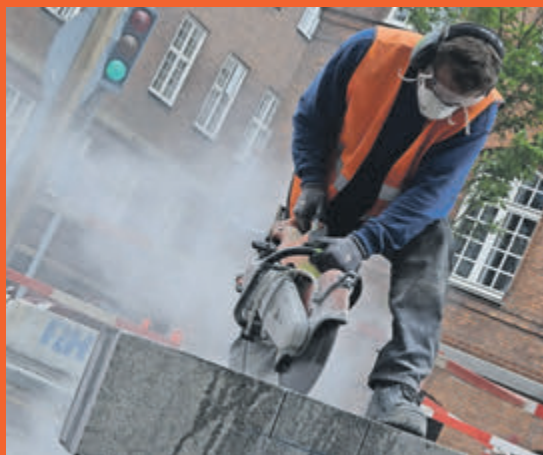
Brolæggeren på arbejde. Der er vand på, men et sug kunne gøre det sidste.
