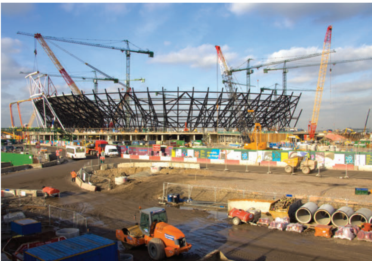
Under byggeriet af London 2012 Olympic Stadium.
