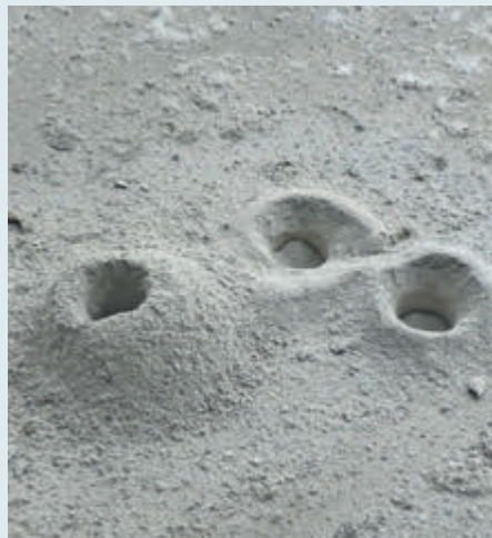
Med et traditionelt bor uden sug, efterlades der en hel del støv.
