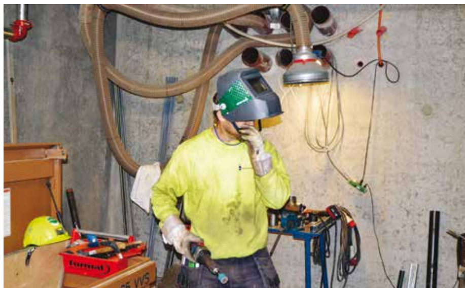
Kim Andersen i gang med svejseriet i varmecentralen i kælderen under tårnet
