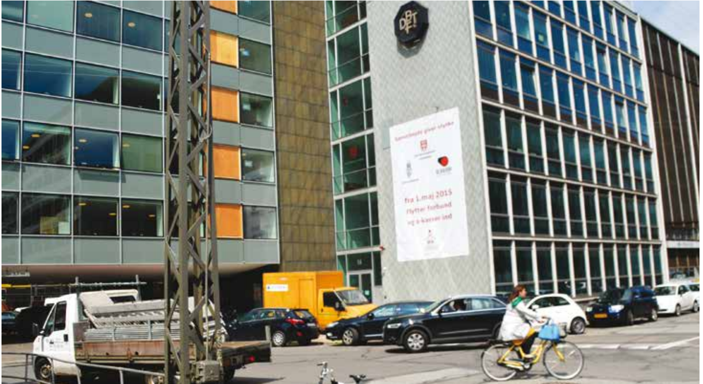
Blik- og Rørarbejderforbundets nye kontorer ligger Nyropsgade 14, 1612 København.
