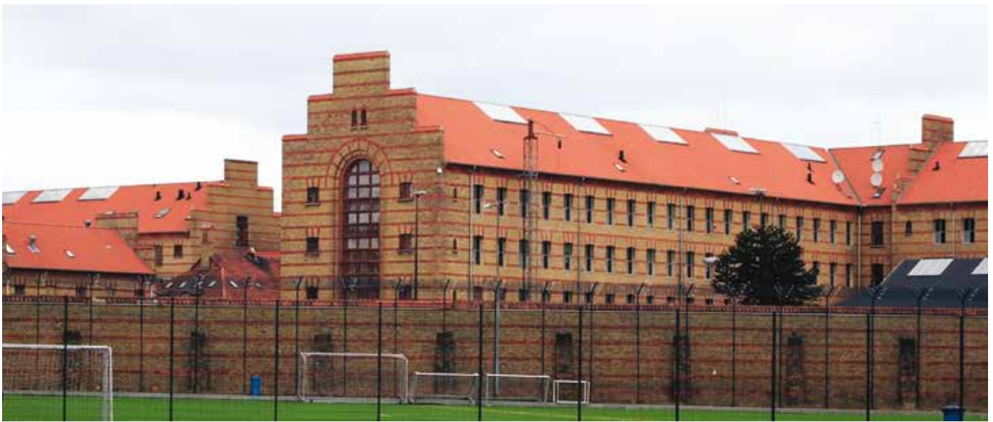
Vestre Fængsel skal have bygget ny retsbygning
