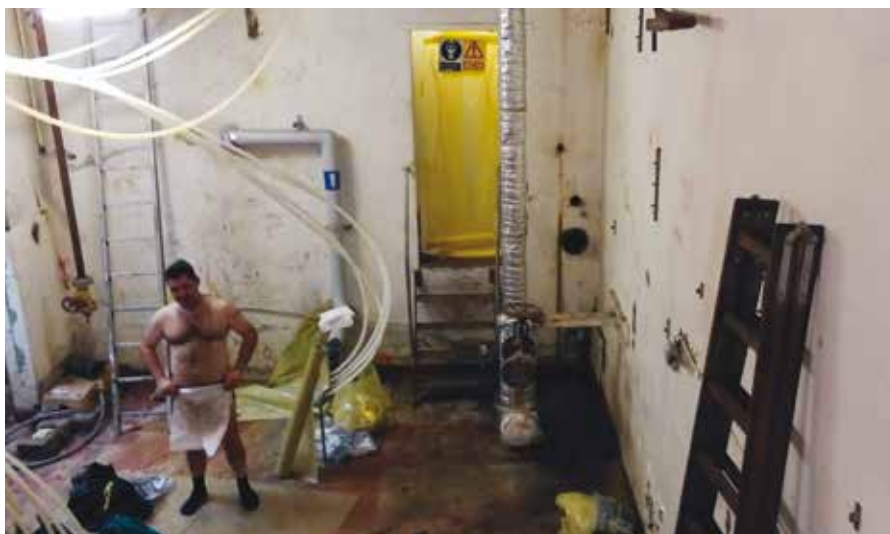
Varmecentral på Tomsgårdsvej. Professionel asbest sanitør. Interessant påklædning.
