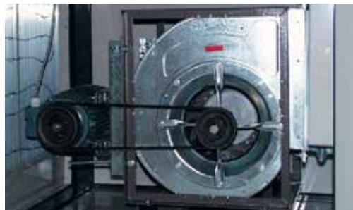
Figur 7.17. Remtrukket ventilator.
