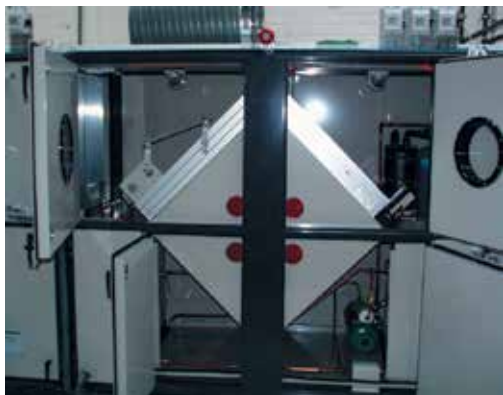
Figur 7.28. Krydsvarmeveksler.
